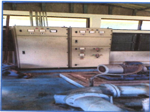
ตู้ควบคุมมอเตอร์เครื่องสูบน้ำแรงสูง
