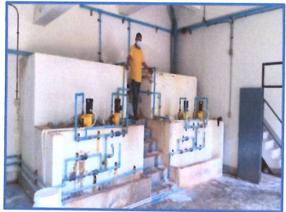
อาคารผลิตน้ำ (จ่ายสารเคมี)
