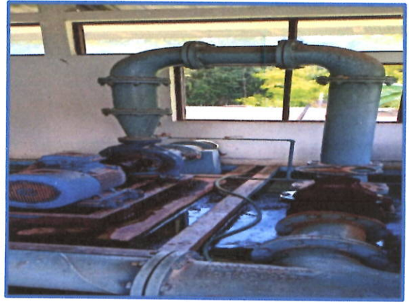
เครื่องสูบน้ำแรงสูง
